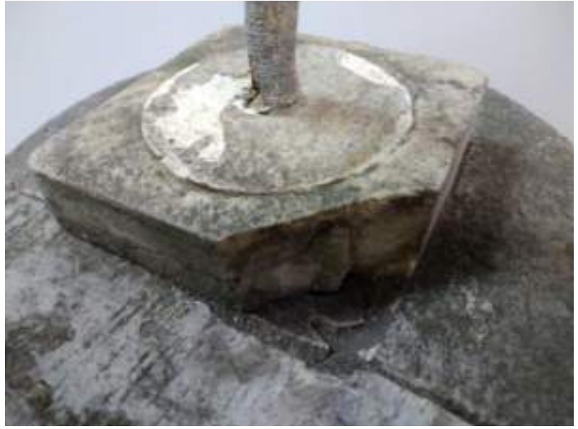
Илл. 5. Фрагмент мемориального памятника Горяйнову А.А. Колонна и подставка-плинт от вазы-святильника. Состояние на момент поступления в реставрацию.
