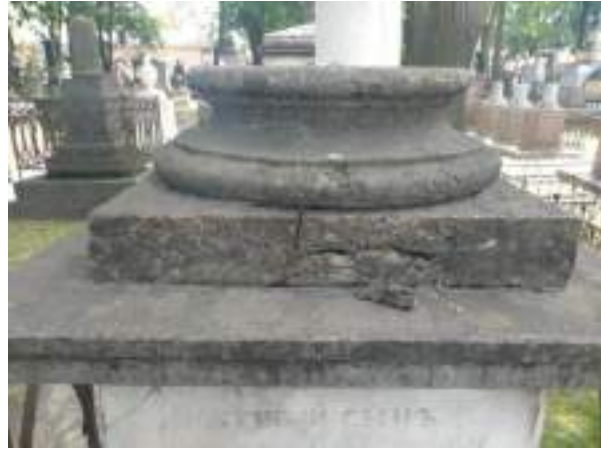
Илл. 9. Мемориального памятник А.А. Горяйнову. Плинт и база колонны. Состояние на момент поступления в реставрацию
