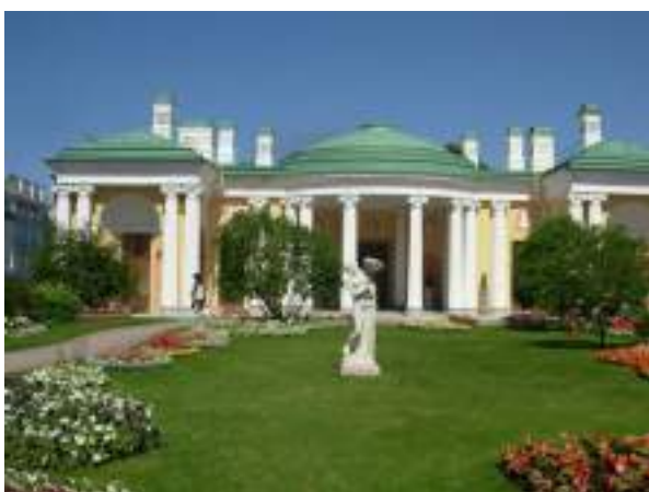
Илл. 3. Южный фасад «Холодной бани» со стороны Висячего сада
