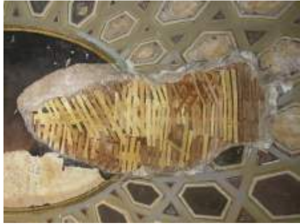
Илл. 44-45. Овальный кабинет. Пробоина в купольной части со времён войны 1941-1944 годов. Заделка пробоины лагами из древесины сосны и обшивка дранкой перед нанесением штукатурного слоя грубой фракции и гипсовой затиркой. 2012 год
