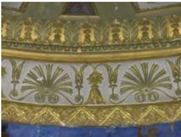
Илл. 42-43. Овальнй кабинет. Фрагмент карниза после консервации и реставрации с выявленным после удаления загрязнений цветным золотом жёлтого и зелёного цветов. 2011 год
