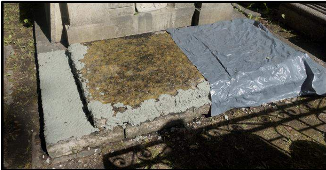
Илл. 22. Удаление загрязнений при помощи компресса
