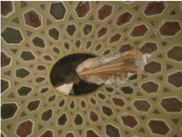
Илл. 44-45. Овальный кабинет. Пробоина в купольной части со времён войны 1941-1944 годов. Заделка пробоины лагами из древесины сосны и обшивка дранкой перед нанесением штукатурного слоя грубой фракции и гипсовой затиркой. 2012 год
