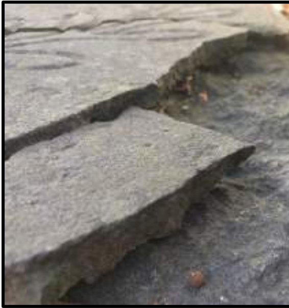
Илл. 9. Надгробная плита М.П. Нефедовой, расслоившаяся по горизонтальной оси
