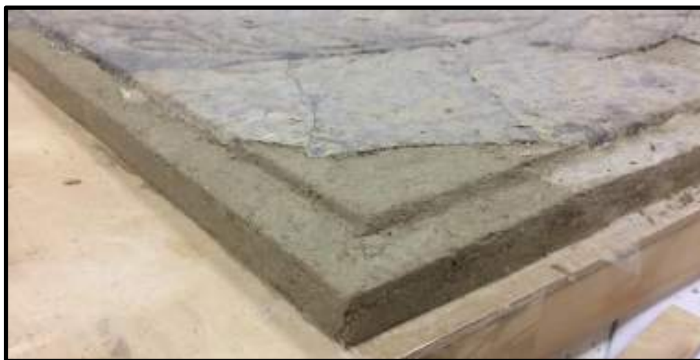
Илл. 19. Восполнение утрат плиты при помощи камнезаменителя
