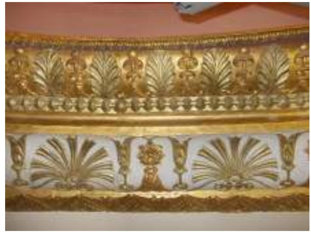
Илл. 42-43. Овальнй кабинет. Фрагмент карниза после консервации и реставрации с выявленным после удаления загрязнений цветным золотом жёлтого и зелёного цветов. 2011 год
