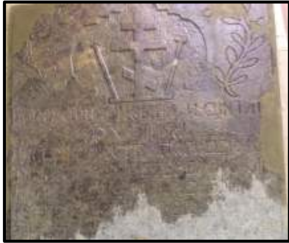
Илл. 21. Покрытие поверхности плиты биоцидным составом
