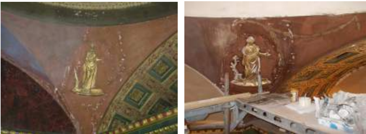
Илл. 36-37. Яшмовый кабинет. Северо-западный парус до реставрации. Парус в процессе удаления поздних красочных слоёв на фоне
