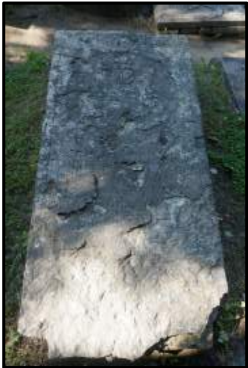
Илл. 5. Следы выветривания на надгробной плите из известняка. Санкт-Петербург, Некрополь XVIII века
