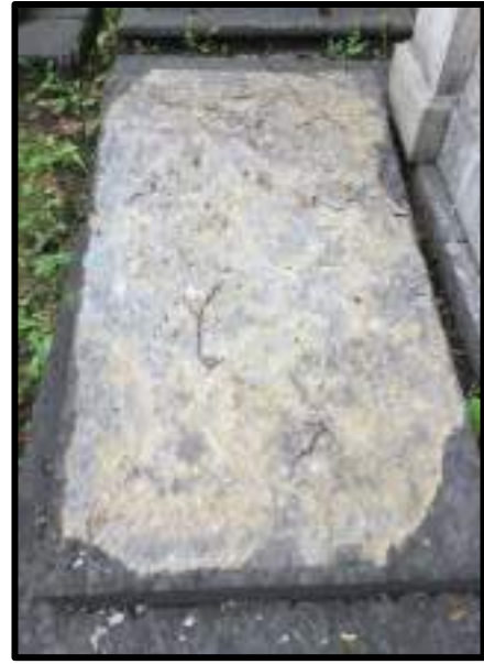
Илл. 10. Нижняя часть расслоившейся надгробной плиты М.П. Нефедовой
