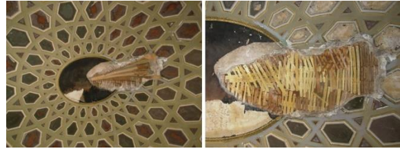
Илл. 46-47. Овальнный кабинет. Пробоина в купольной части со времён войны 1941-1944 годов. Заделка пробоины лагами из древесины сосны и обшивка дражкой перед нанесением штукатурного слоя грубой фракции и гипсовой затиркой 2012 год
