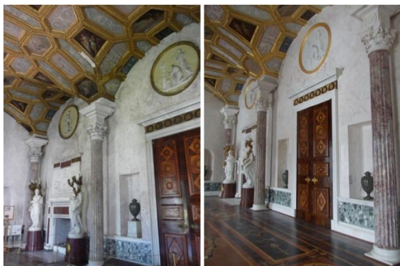
Илл. 28-29. Фрагмент южной стены Большого зала Агатовых комнат до и после консервации и реставрации всех видов отделки. 2009-2012 годы
