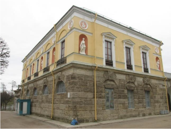
Илл. 1. Северный и западный фасады павильона «Холодная баня» со скульптурой в нишах на втором этаже
