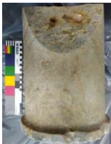
Илл. 13. Фрагмент памятника А.А. Горяйнову. Колонна. После устранения поверхностных загрязнений и старых мастиковок
