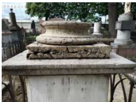
Илл. 18. Фрагмент памятника А.А. Горяйнову. Плинт под базой колонны. После удаления поверхностных загрязнений и удаления старого мастиковочного материала.
